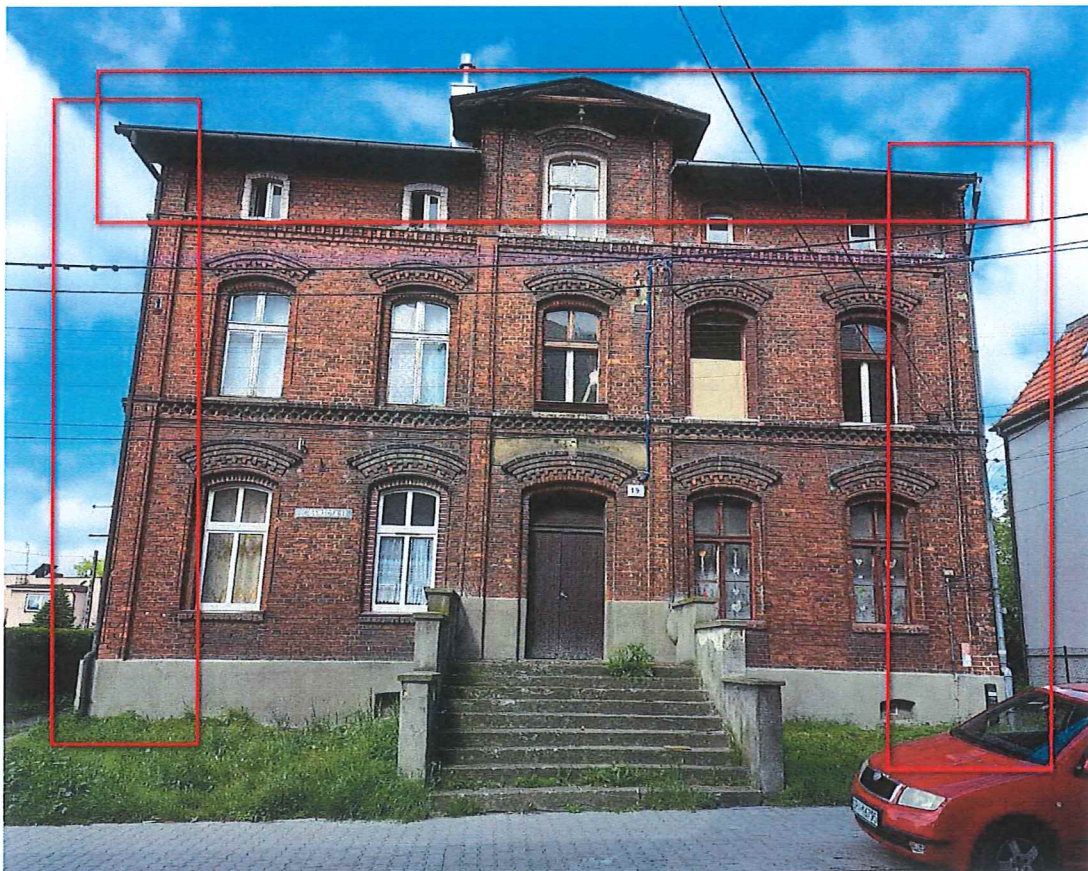
Fot. 1. Widok elewacji frontowej budynku głównego – zaznaczone orynnowanie oraz rury spustowe do wymiany.
